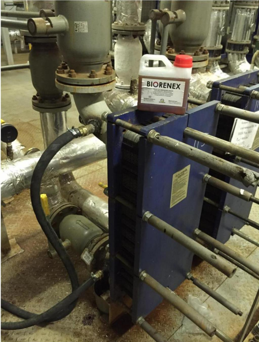
2. В ходе проведения химической очистки теплообменника производились регулярные замеры РН раствора. По достижению РН значений 3,5 раствор сливали, готовили новый. В связи с большим количеством накипи промывка теплообменника производилась в два этапа.
